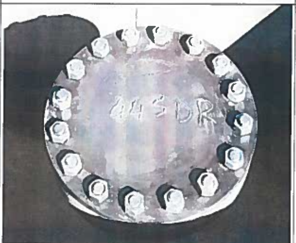
Foto 10. Montat blinda inscriptiionata cu numarul sondei
