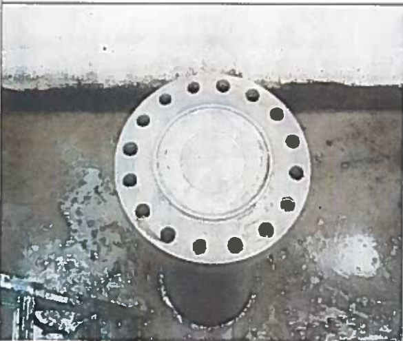
Foto 9. Nivel ciment la zi
