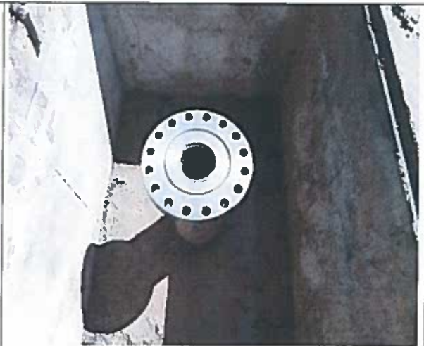
Foto 2. Refacut etansare cap coloana
