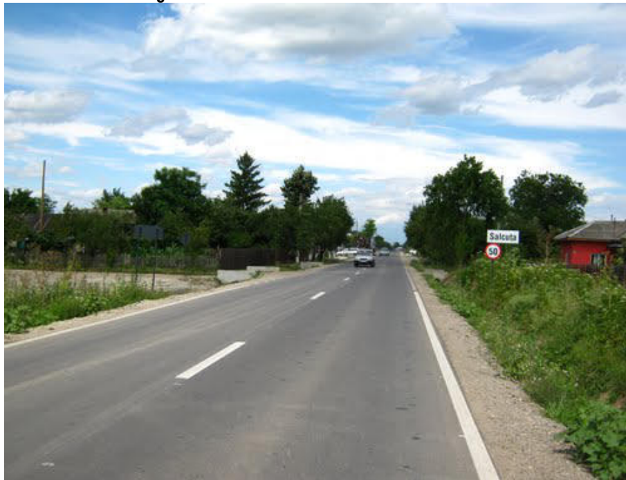
Figura nr. 37 Starea actuala a Drumului Sudului
