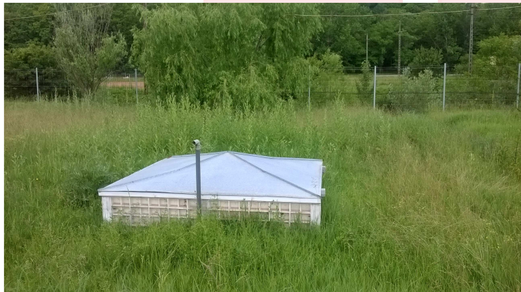
# verificarea statiei de epurare
