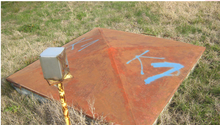
#verificarea puturilor de apa
