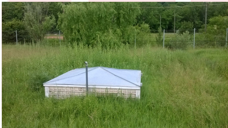
# verificarea statiei de epurare
